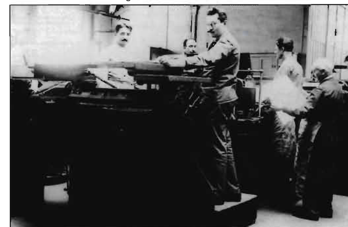
Machine à perforer les feuilles de timbre (1900 - 1945).
