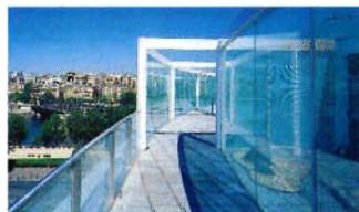
La terrasse de la Maison de la Culture du Japon à Paris. (Photo Luc Boegly- Photothèque Quillery)
