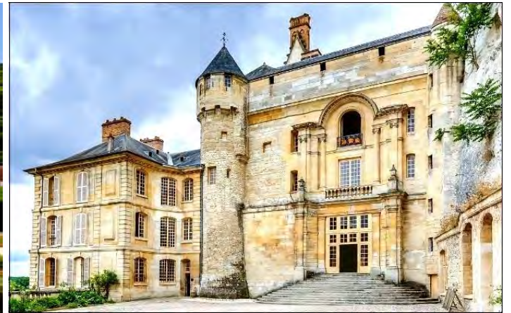
L'entrée monumentale de la cour d'Honneur, percée dans le rempart et adossé à ma falaise.
