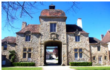
Ancienne porte d'accès au prieuré
