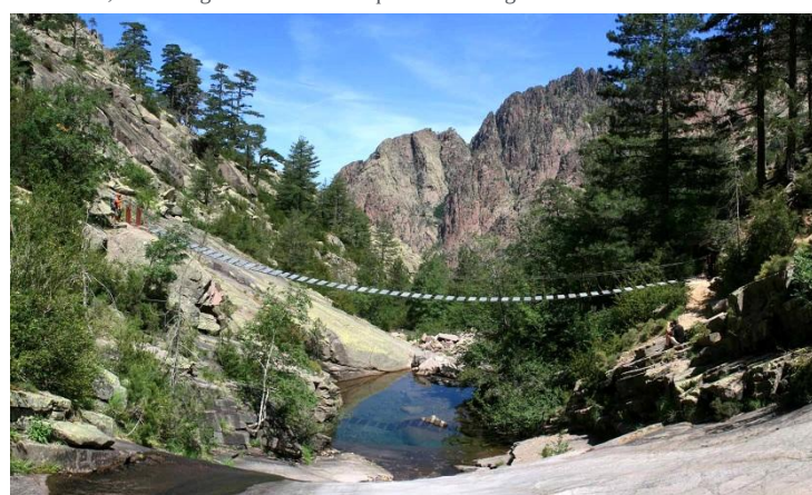
La passerelle suspendue de Spasimata
