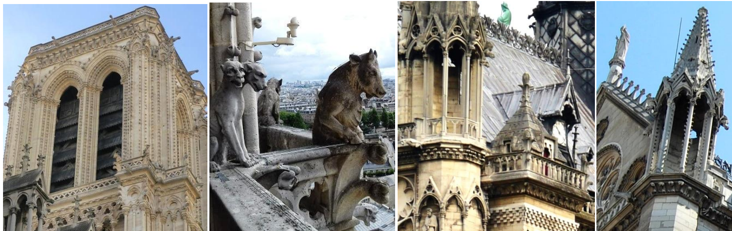
Tour Nord, avec à l'angle de la façade Nord-Est, la galerie des chimères (le Cerbère et le Taureau).
