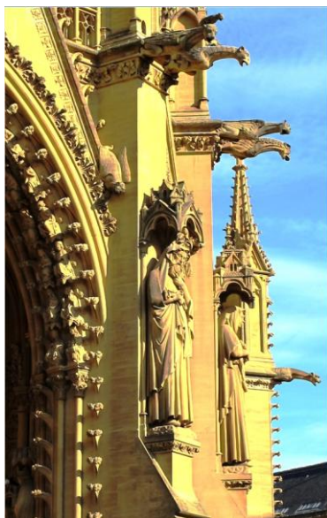
Détail de la façade occidentale, à droite du portail.
