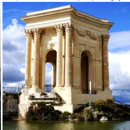
Le château d'eau monumental et le grand bassin.
