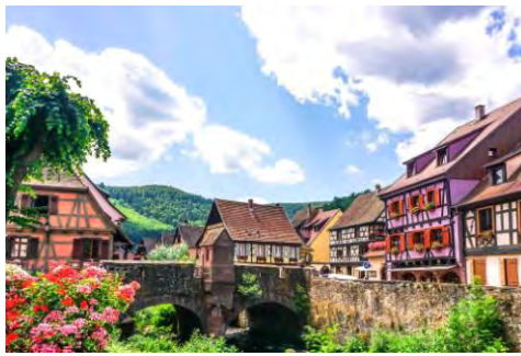
Pont fortifié de 1514, sur la Weiss
