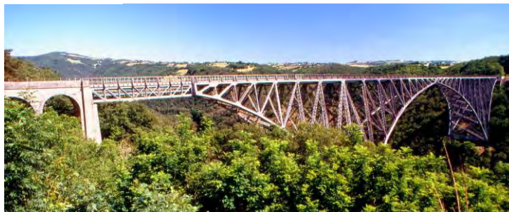
Vue générale de l'ouvrage ferroviaire franchissant la profonde vallée du Viar.
