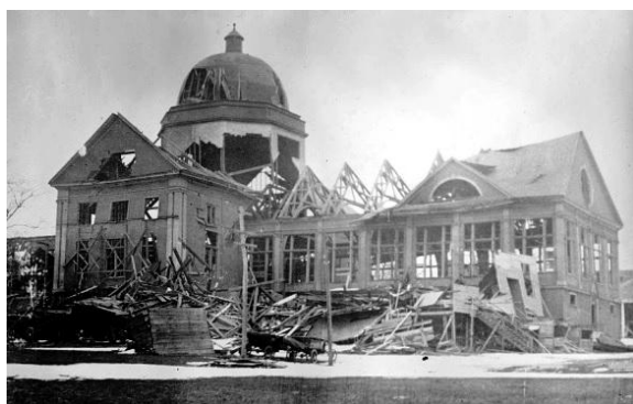
Un bâtiment endommagé par le souffle de l'explosion.
