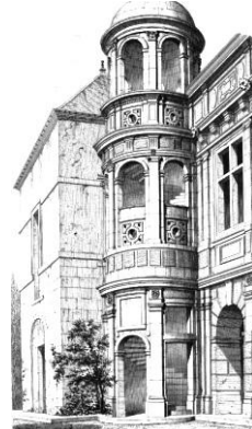
Tourelle escalier ajourée
