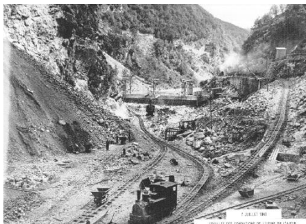
Chantier des fondations du barrage (7 juil.1940)
