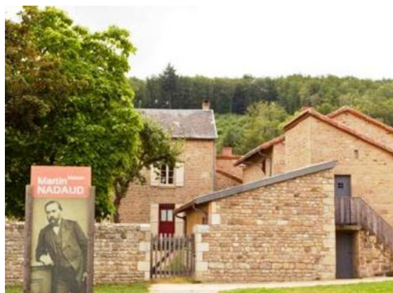
L'ensemble de "La Martinèche", après restauration
