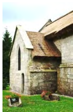
Détail du toit en chaume
