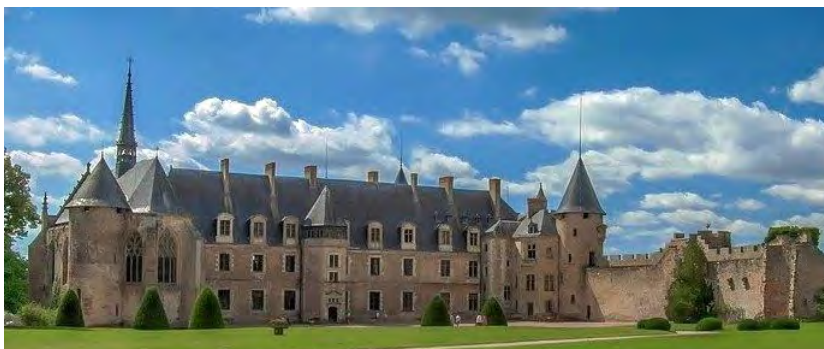
Façade côté cour, tour, chevet de la chapelle, aile Renaissance et partie féodale
