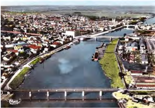
Vue aérienne des Chantiers de Chalons, rive Est
