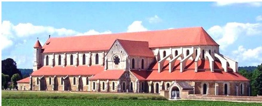
Façade et bras Sud du transept, cimetière longeant l'ensemble du bâtiment jusqu'au chevet(Est)
