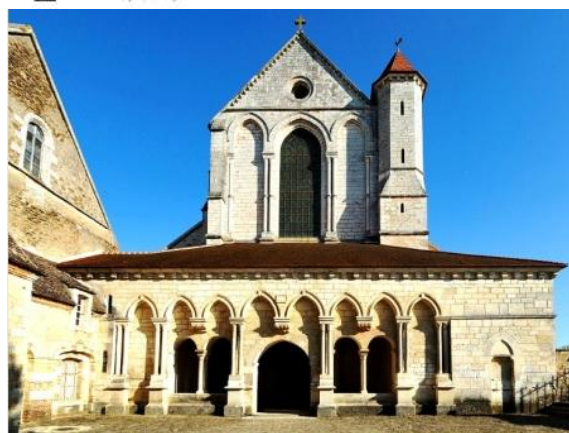
Façade occidentale : porche et narthex de l'abbatiale (Ouest)
