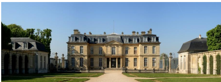
Façade Sud : vue générale de l'édifice depuis la Cour d'honneur.
