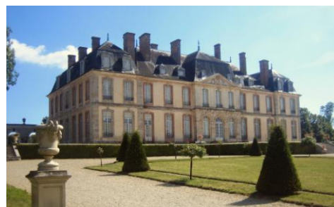
Façade Nord du château
