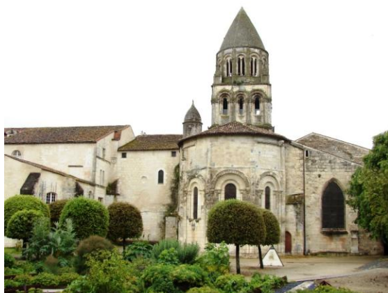
Bâtiments conventuels, jardin, arrière du chœur, sacristie et clocher
