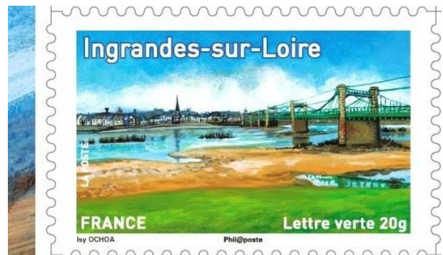
Le pont (550 m) et la ville d'Ingrandes sur la rive droite de la Loire
