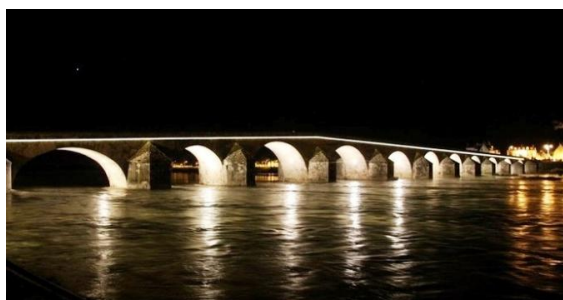
Le Vieux-Pont sur la Loire
