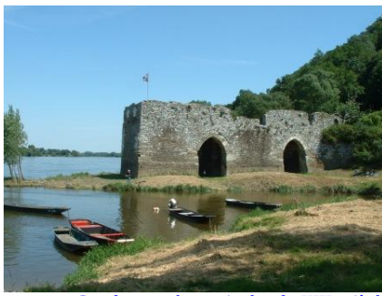
Ces deux arches ogives du XIII e siècle, abritaient en fait un ancien moulin seigneurial : des "roues pendantes" descendaient sous les deux arches.
