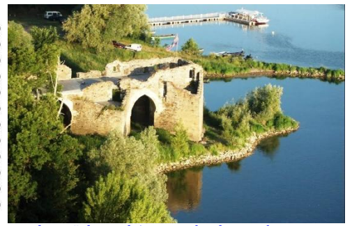
Ces deux arches ogives du XIII e siècle, abritaient en fait un ancien moulin seigneurial : des "roues pendantes" descendaient sous les deux arches.
