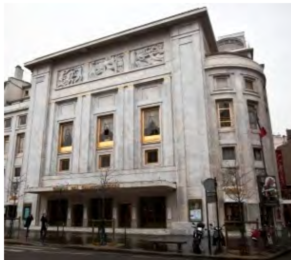
Façade du bâtiment
