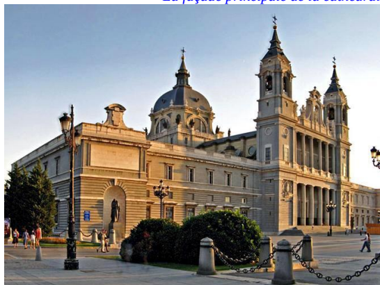
Façade Nord / Est
