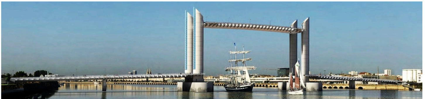
L'image de synthèse montrant le passage du 3 mats "Belem" sous le pont "Jacques Chaban-Delmas" en position haute, illustre parfaitement l'utilité de la travée levante.
