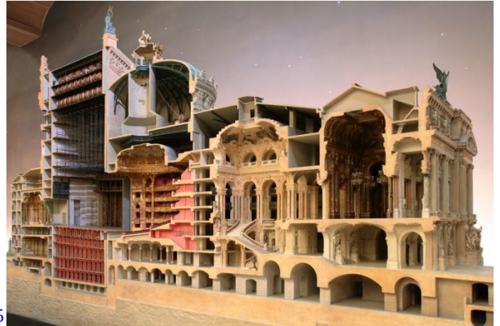
Maquette de l'Opéra au musée d'Orsay montrant, en une coupe longitudinale, ses volumes et circulations intérieurs
